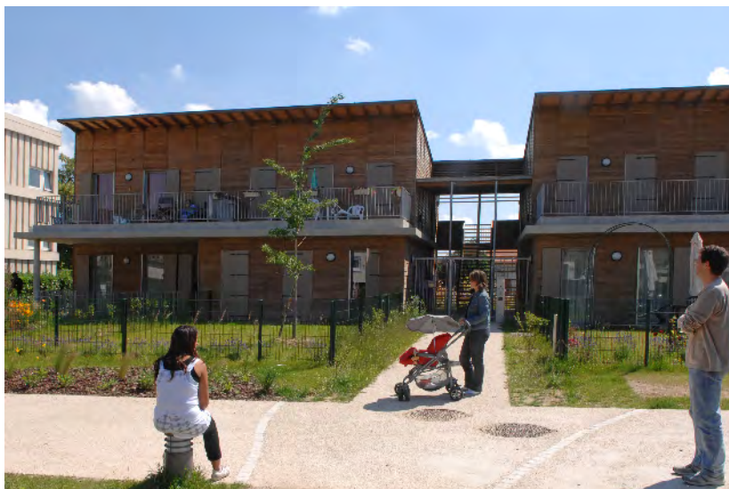
Entre tradition et innovation : construction en ossature bois dans l'ilot Frassati à Courtry (77).
