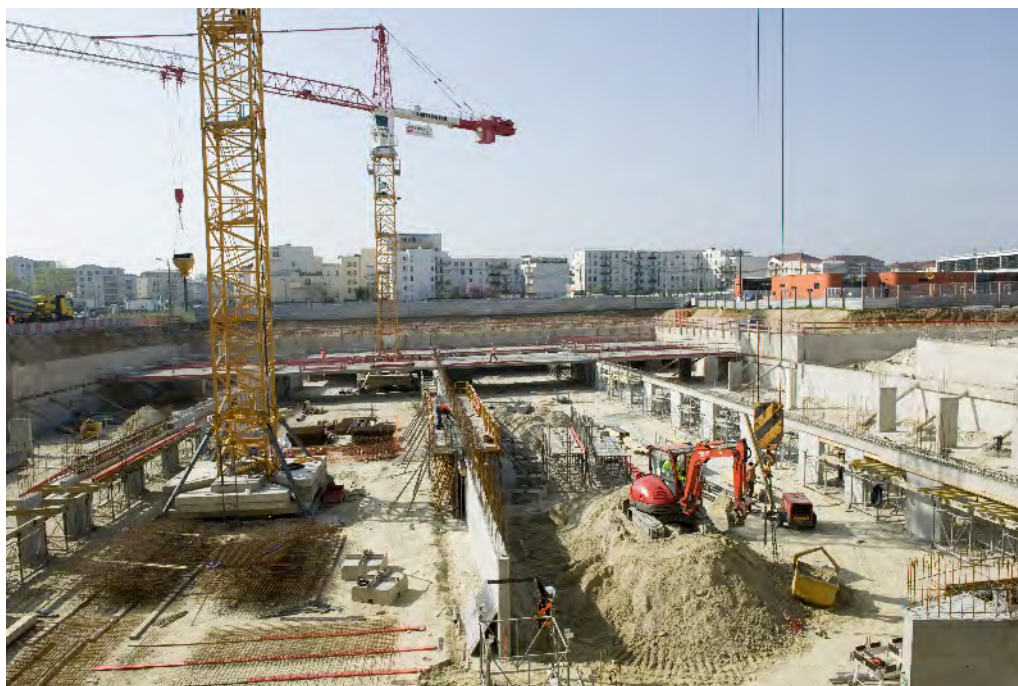
Poids du stationnement dans les projets urbains : ce parking-relais en cours de construction renchérit le coût du programme mais permettra de limiter les déplacements automobiles. © Bernard Suard/MEDDE
