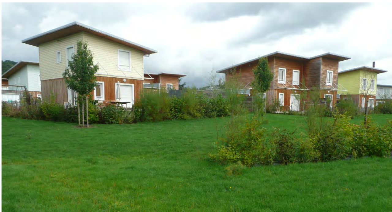
Charte de l'habitat durable dans l'Eure : s'efforcer de faire le lien entre production de l'habitat et nouvelles formes urbaines comme pour les 68 logements sociaux HQE ZAC des Étangs à Pont-Audemer. © CAUE 27
